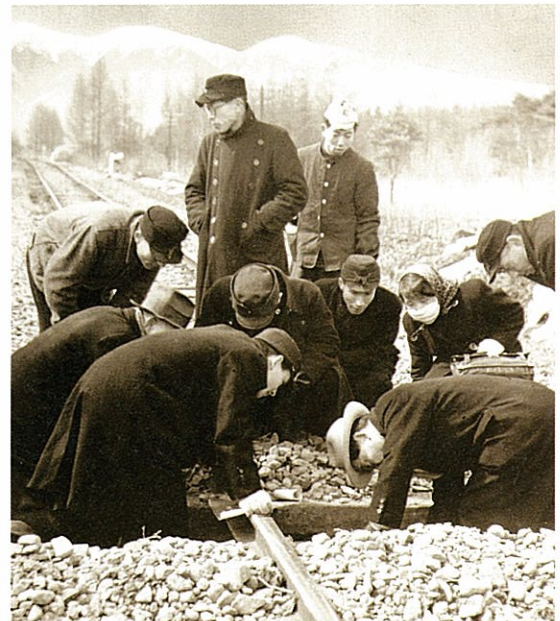
凍上で隆起した線路の下の土壌を調べる。長野県小海線で。右手前宇吉郎、その後中山久子。@UNlimited
