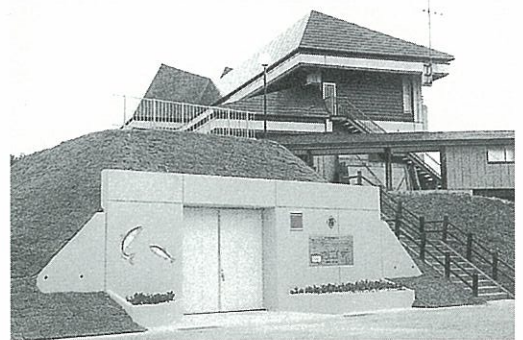
手前が雪をためておく雪室の扉。後方の建物が冷房する実習館。
