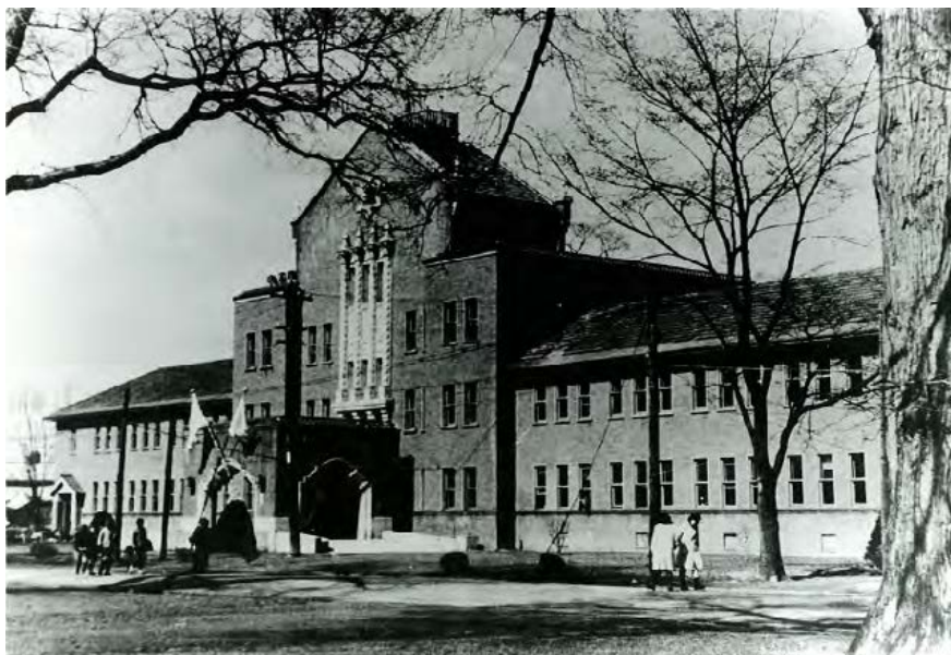
写真2 旧低温科学研究所の建物（新庁舎の落成に合わせた開所式の日に撮影、1943年9月15日）（写真提供：低温科学研究所）。
