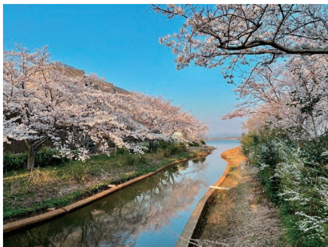
地震後は川岸が歪み、ところどころ陥没が見られる。 (2025年4月7日・館職員撮影)
